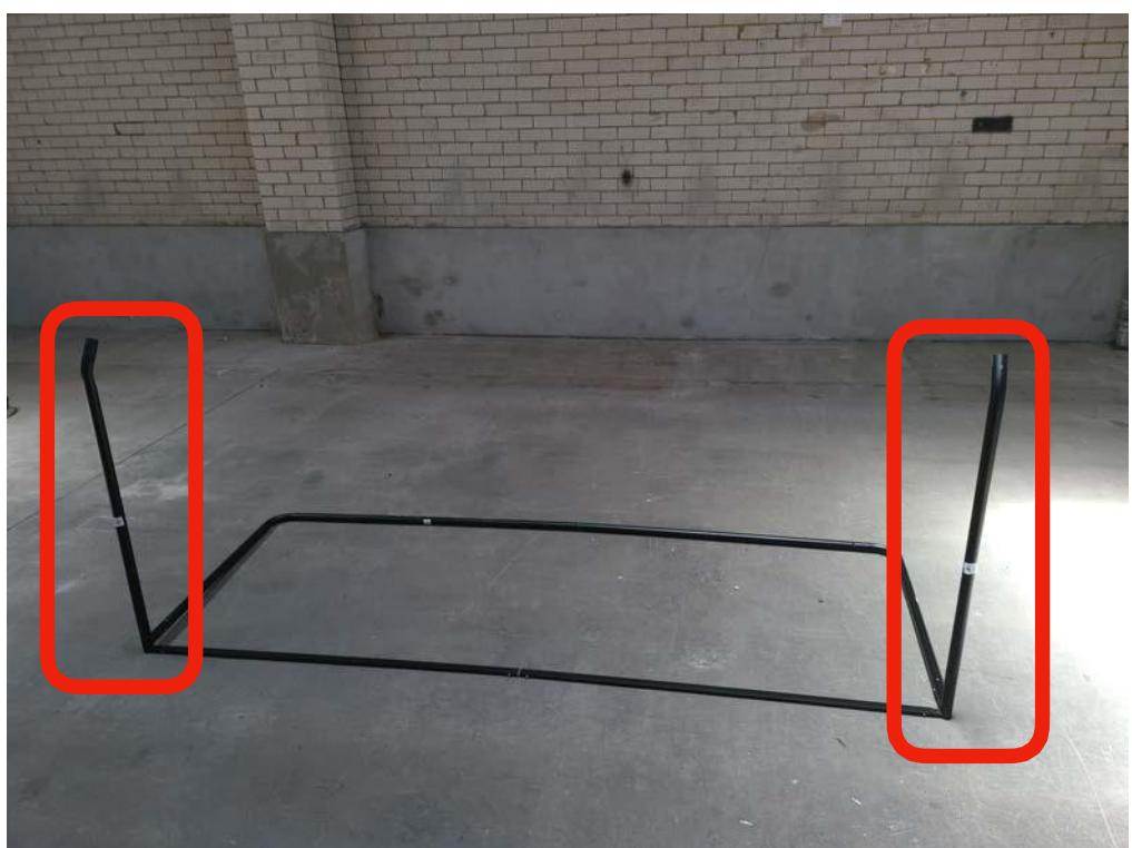
8) メインネットを用意します。下部のスリーブを、ステップ7で取り付けた2本の4Cに接続します。
